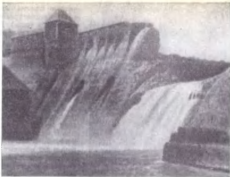
Рис. 1. Вид с нижнего бьефа на плотину Эдер, разрушенную английской авиацией 16 мая 1943 года
