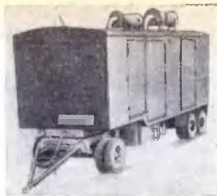
Рис. 2. Английский дизельный электроагрегат мощностью 250 кВт
